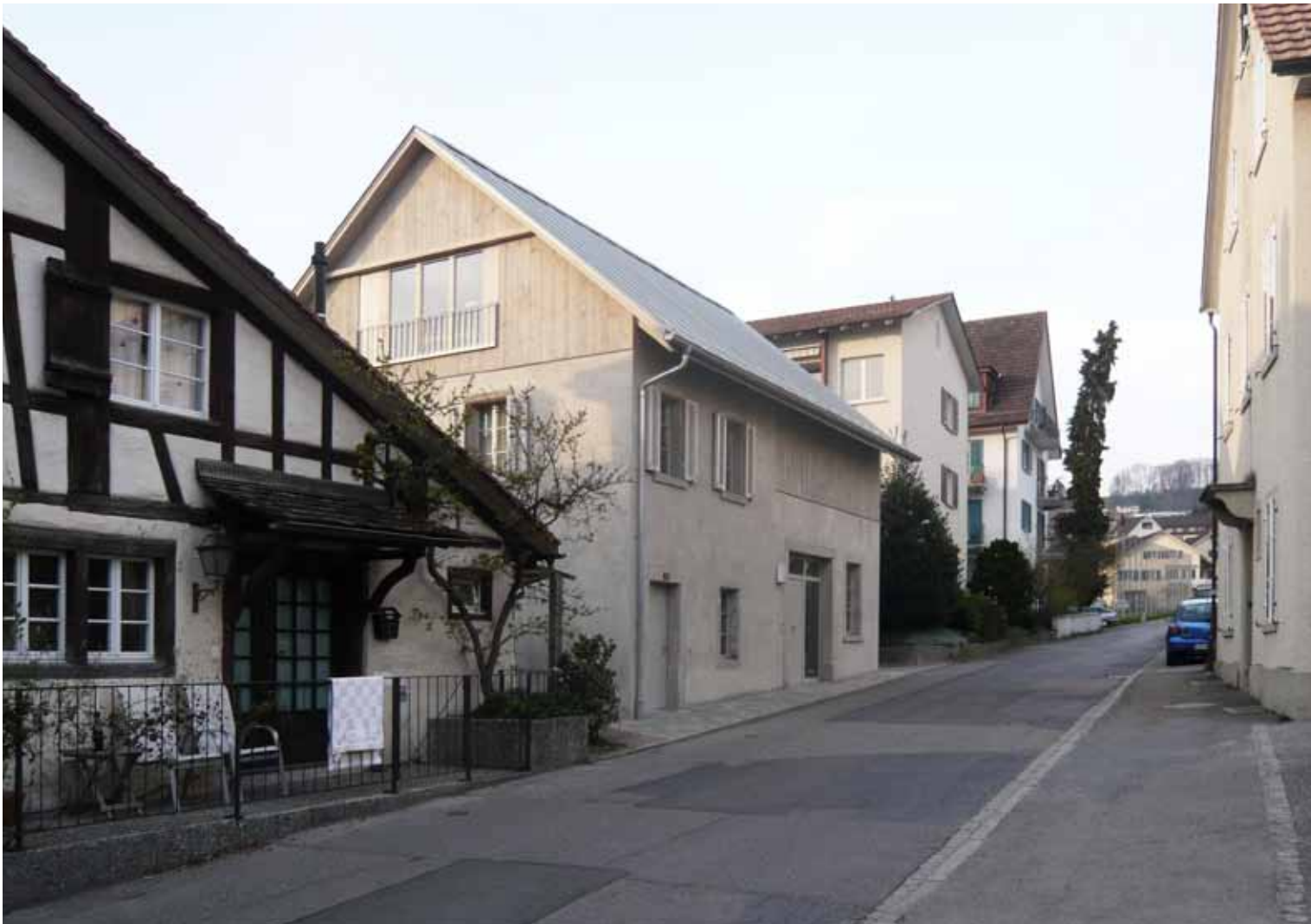
Strassen- und südliche Giebelfassade im Abendlicht
