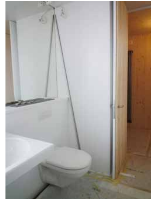
Plan oben links: Ausführungsplan Badezimmer mit Einbauschränken und Türen in gestrichener Dreischichtplatte (Ausschnitt), Plan unten links: Ausführungsplan Badfenster mit schiebbarem Spiegel; Bilder oben: Pulverbeschichtete Aluminiumbleche in der Dusche und hinter den Apparaten schützen den Holzbau.
