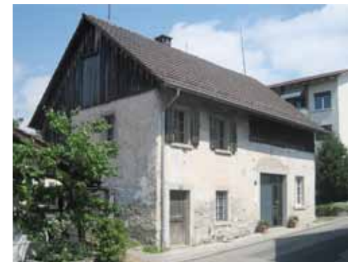
Gebäude vor der Sanierung und dem Umbau
