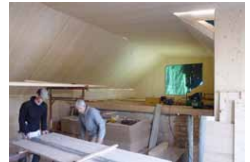
Platten: Dreischichtplatten schliessen die von der primären Tragstruktur vorgezeichnete Raumfigur ab und steifen das Sparrendach aus (primär in Längsrichtung, zusätzl. gegen Durchbiegung).
