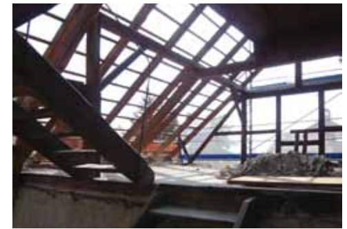
Bestehender Dachstuhl vor dem Rückbau des Holzwerks
